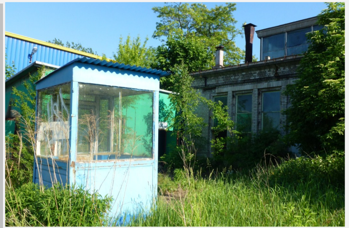
▲ Dawna budka strażnicza. Na prawo budynek Wydziału Obróbki Powierzchniowej P3.
