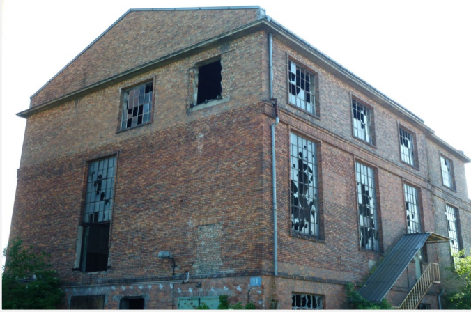
▲ Budynek kotłowni. Na lewo znajduje się, niewidoczny na zdjęciu, komin.
