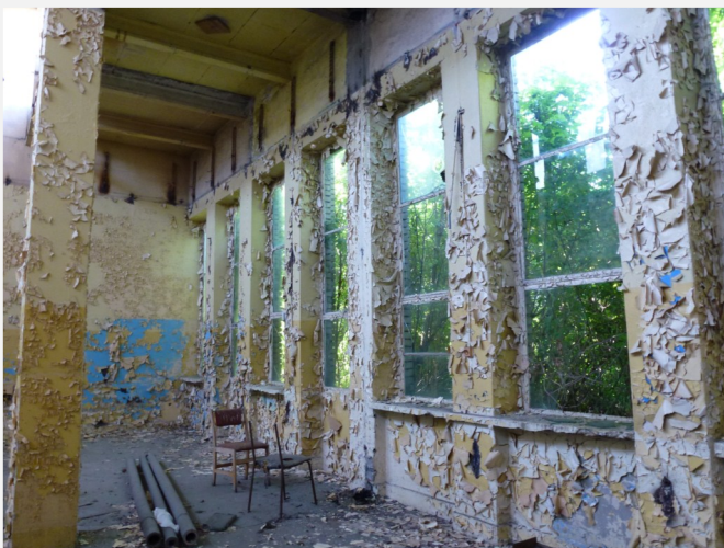
▲ Wnętrze budynku Wydziału P3. Dawniej znajdowały się tu różne chemikalia.
