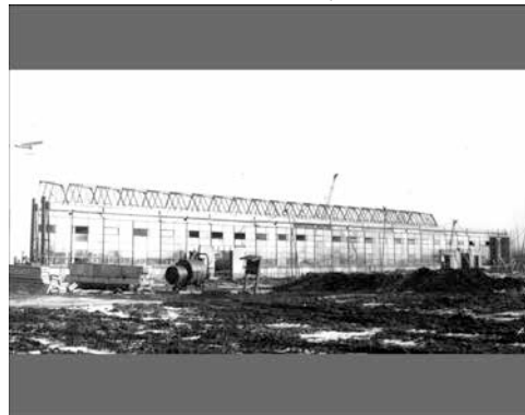
249. Hala montażu P-2 w budowie
