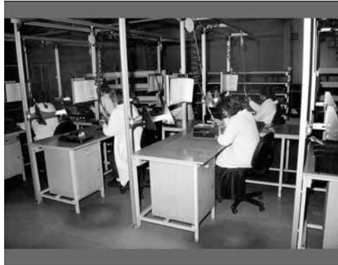
396. Na linii montażowej
