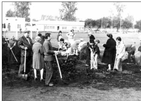
151. Przy budowie stadionu
