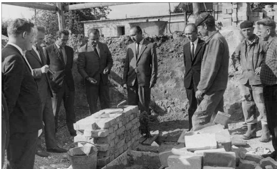
48. Wmurowanie aktu erekcyjnego pod budynek zaplecza
