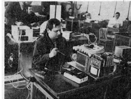
Fragment linii montażowej dziurkarek D-102, tzw. montaż elektroniczny. Widomy przykład naszego wrastania w produkcję urządzeń elektronicznych ZMP Błonie, zakładu który jeszcze do niedawna znany był z produkcji zegarków Bionex. Nasza przyszłość to nowoczesne czytniki, drukarki i dziurkarki do maszyn matematycznych z przeznaczeniem na eksport.
