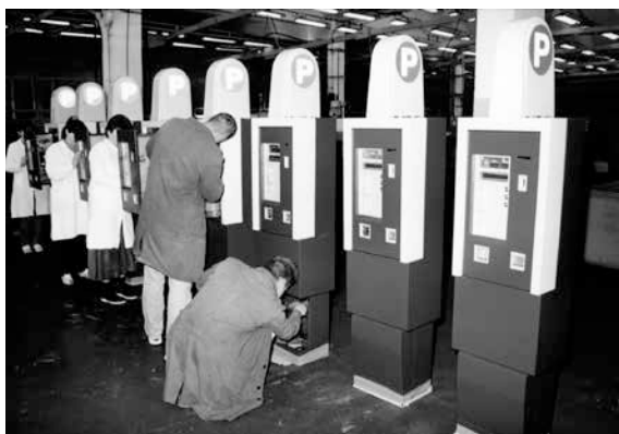
118. Montaż parkometrów dla m.st. Warszawy
