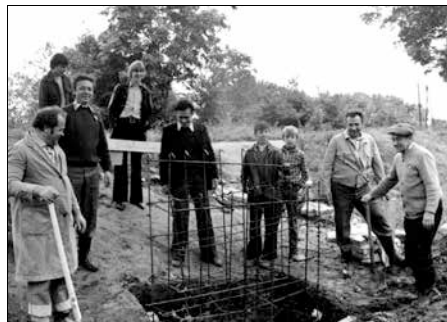
152. Budowa kładki nad Rokitnicą
